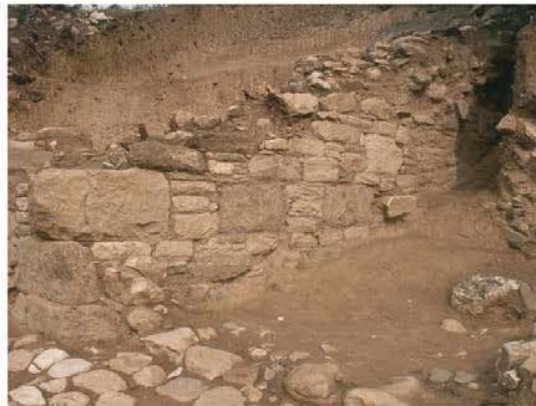
Fig. 52. Argilos. Mur de soutènement du bâtiment G, vue vers le nord-ouest. (Archives Argilos 2003 - cliché : Martin Perron)
