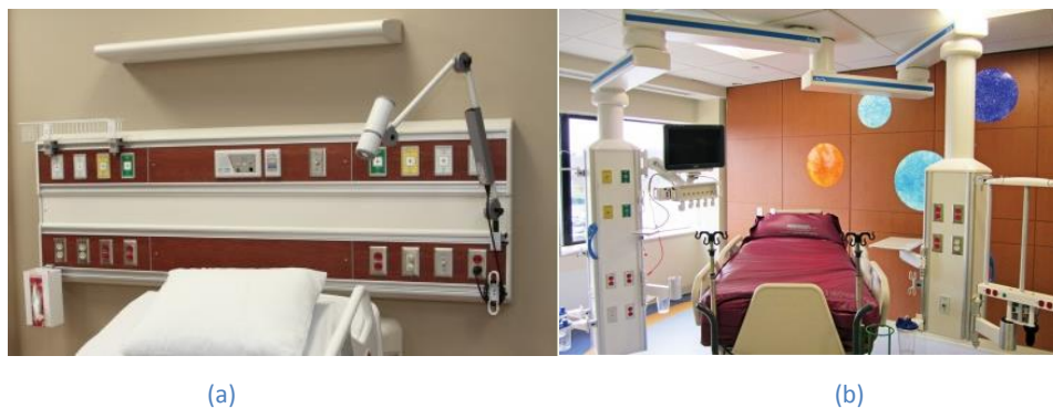
Figure 6 : (a) Exemple de mur modulaire, (b) exemple de bras articulés, Amico® 16
