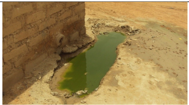
Photos 4&5 : Abris faisant office de toilette avec un trou au sol pour l'évacuation des excréments et un trou au mur pour l'évacuation des eaux usées dans la nature dans une concession au quartier Nonghin
