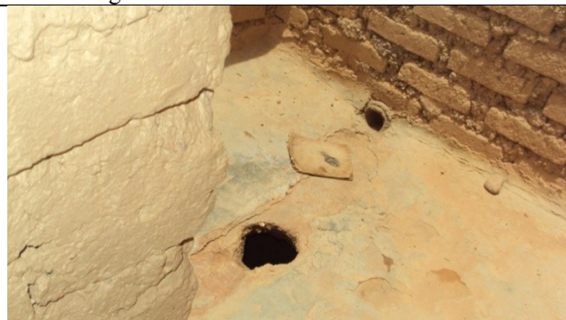
Photos 4&5 : Abris faisant office de toilette avec un trou au sol pour l'évacuation des excréments et un trou au mur pour l'évacuation des eaux usées dans la nature dans une concession au quartier Nonghin
