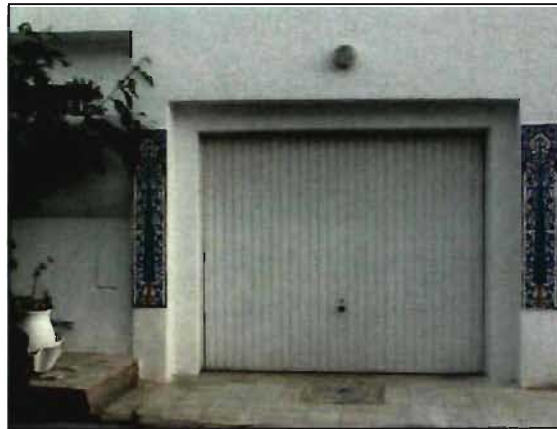
Figure 56 : panneaux extérieurs, maison 8.
