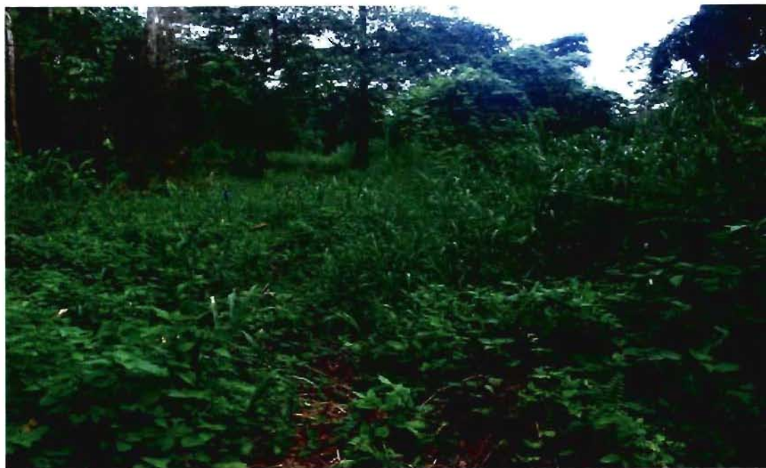
Figure 5.9 La végétation recouvre entièrement la chaussée empierrée pocora (Photographie : Eddy Lachapelle).
