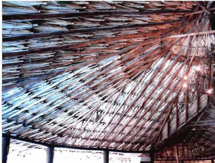
Figure 7.9 Exemple d'un toit sans support central (Photographie : Eddy Lachapelle).
