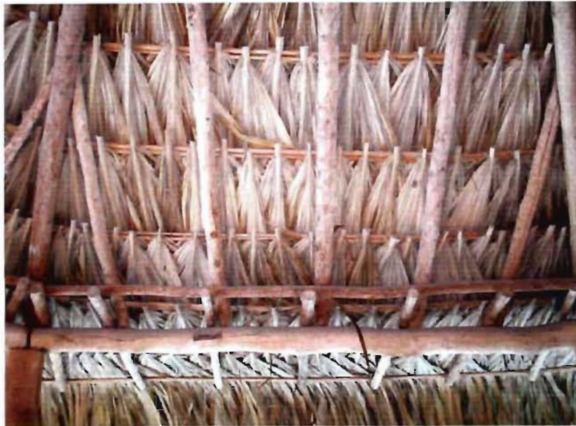
Figure 7.8 Exemple d'un toit de palme (Photographie : Eddy Lachapelle).
