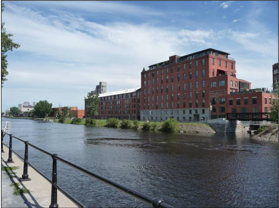
Figure 20 : L'ensemble de la Redpath vu du côté nord du canal de Lachine.
