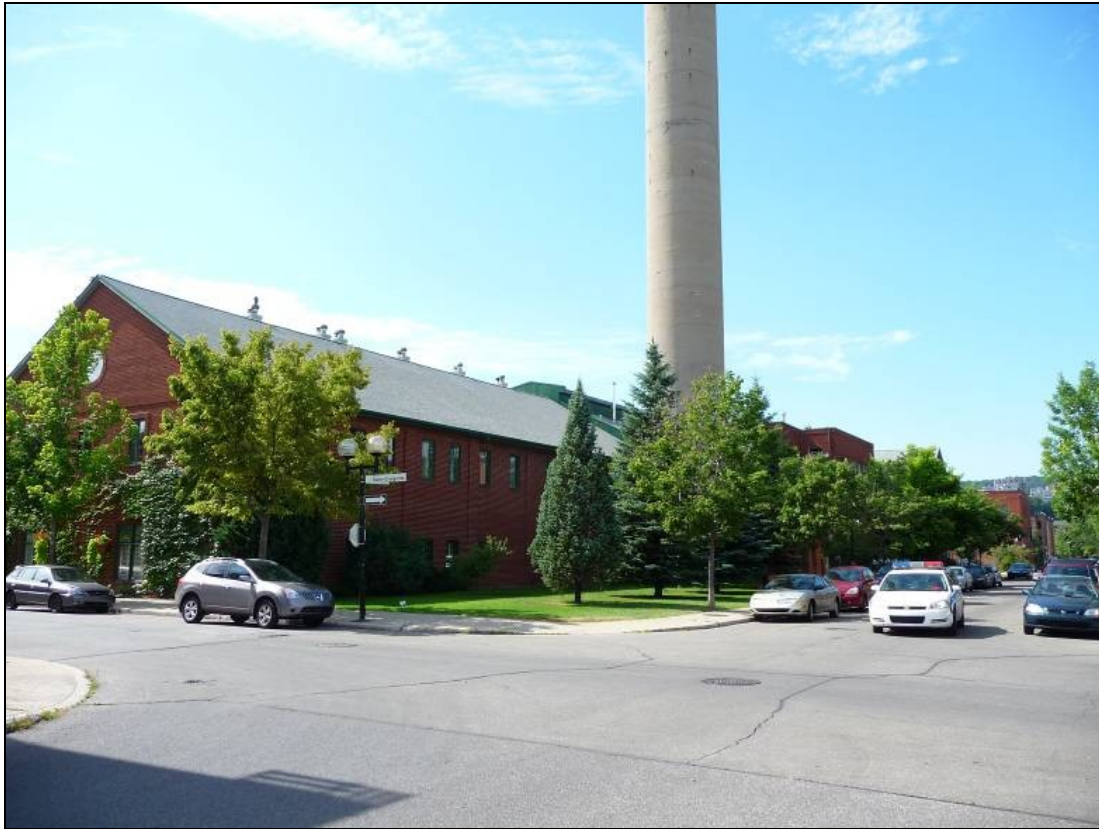
Figure 18 : Cheminée de l'ancienne usine Stelco située au cours Dominion, au carrefour des rues Duvernay et Dominion.
