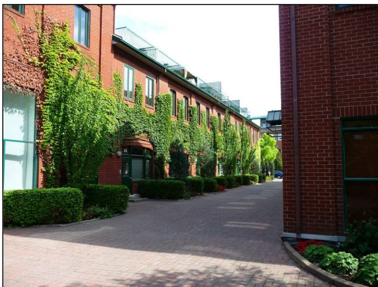
Coursive à l'intérieur du cours Dominion.
