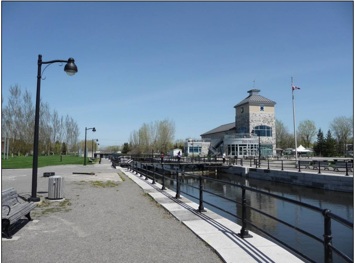
Figure 29 : Vue vers l'est de l'écluse de Lachine (no. 5), du chalet d'accueil du lieu historique national du Canada du Canal-de-Lachine et du pont Huit.
