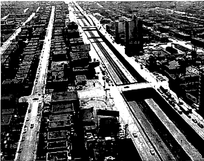
Figure 3.2. L'autoroute Décarie à Montréal (Source : MTQ)
