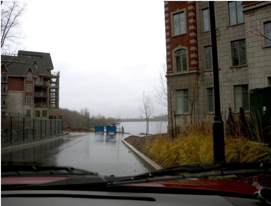
Figure 31_Accès pour les résidents des condominiums du projet « Saint-Bruno-sur-le-lac », Saint-Bruno-de-Montarville. 45 (Photo : Bergeron, 2009 - Parcours R10).
