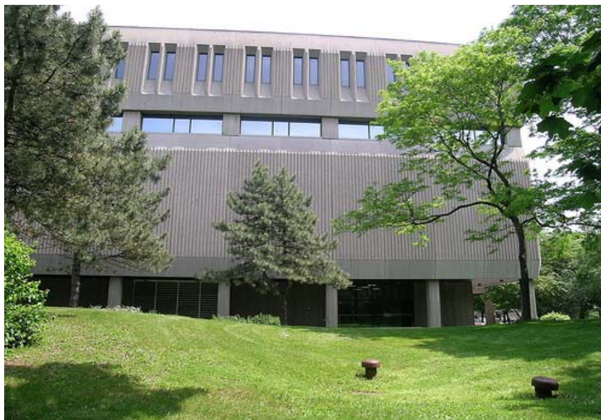
Pavillon Decelles. Vue latérale avec stationnement à proximité.
