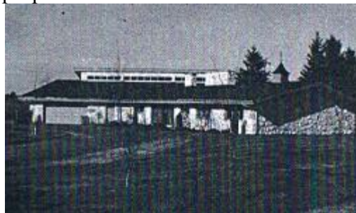
Image 151 : Une résidence du boulevard Allard qui appartient à l'époque à un propriétaire d'industrie
