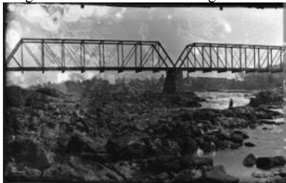
Image 32 : Pont ferroviaire et forges au loin
