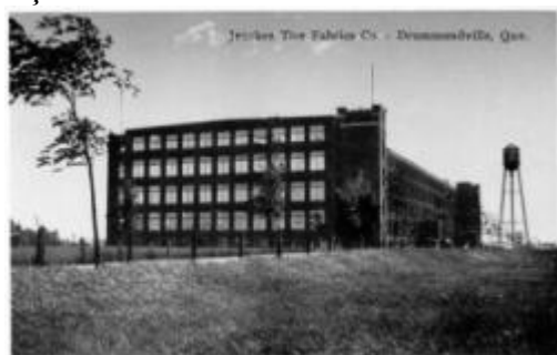
Image 60 : Jenckes Tire Fabric, façade rue Des Écoles
