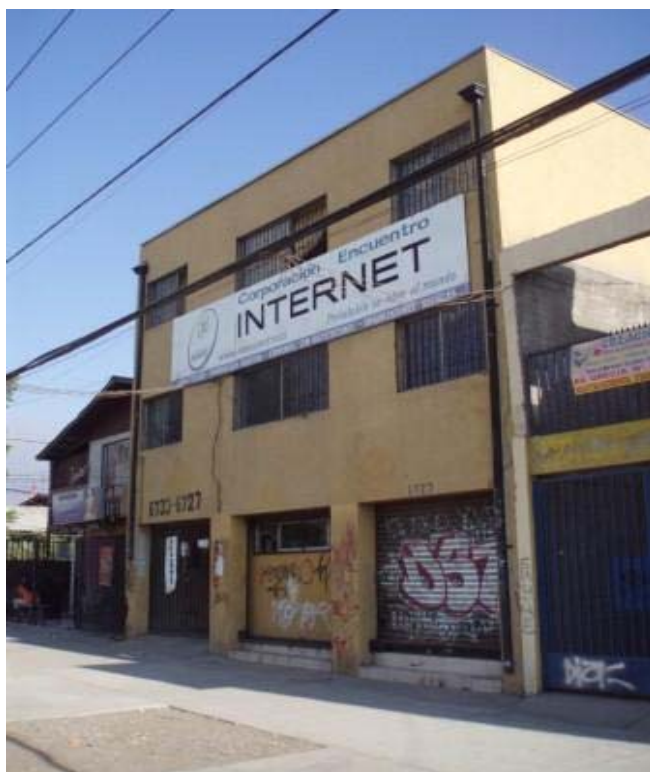
Photo 13. Le bâtiment de la Corporation El Encuentro dans le quartier Lo Hermida à Santiago. Au premier étage se trouve le télécentre et une salle d'événements. Au deuxième, se trouve la salle de formation et au troisième, les bureaux administratifs et le bureau de la radio communautaire.
