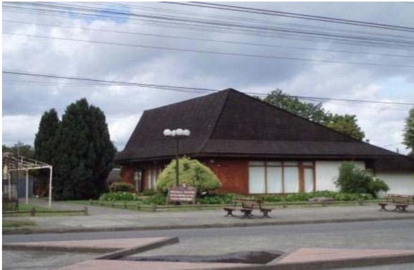
Photo 3. La bibliothèque municipale de Villarrica. La forme du toit répond aux besoins du climat, Villarrica est une des villes où il tombe le plus de pluie pendant l'année. Au sud, les constructions en bois sont très communes, le Chili étant un pays forestier.
