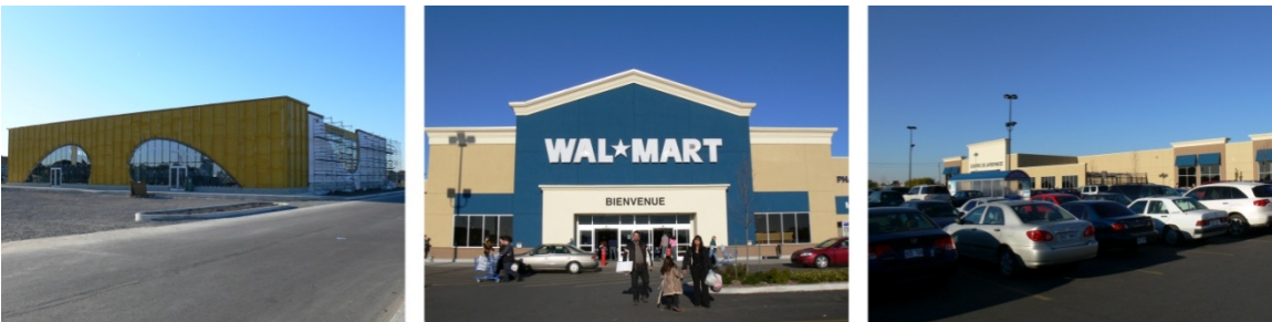
Section WalMart du Quartier DIX30 / En construction (Source William Luis)
