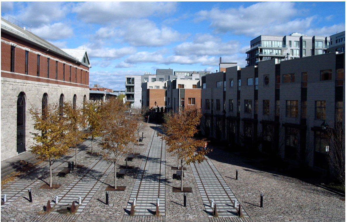
Fig. 11. Mixité des typologies dans le faubourg Québec. Le square et la gare Dalhousie (gauche), le projet Art de Ville (droite, 2002) et en arrière-plan, le Solano (2007-2009). Photo: A. Maltais.
