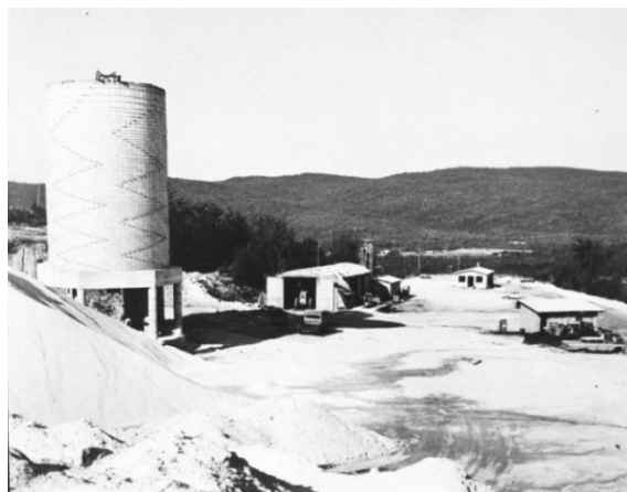
Figure 18 : Mine de silice, vers 1950
