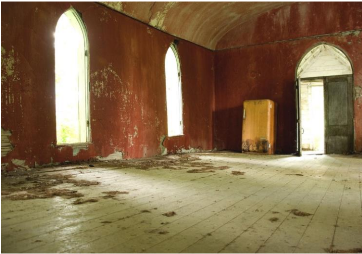
Photo 16: Église, Grenville, Québec, 2011.
