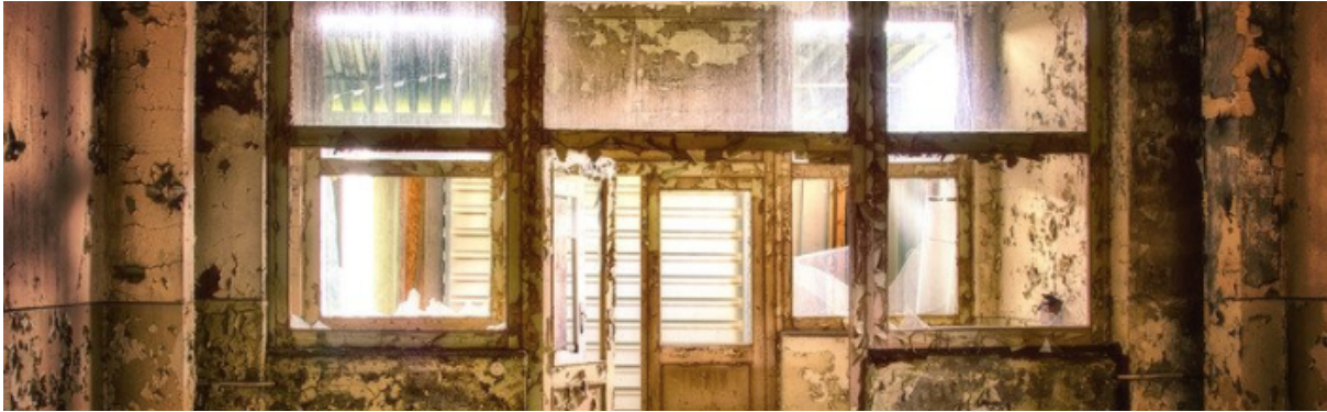
Figure 70 Tama66, Abandoned building interior, 16 août 2017.
