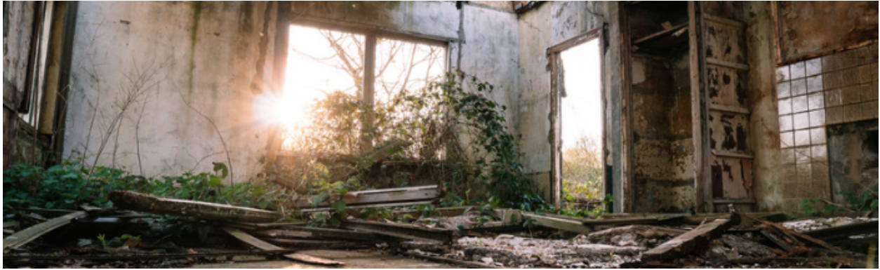
Figure 1 Matthias Groeneveld, Remaining walls of ruined abandoned building, mise en ligne le 20 avril 2020.
