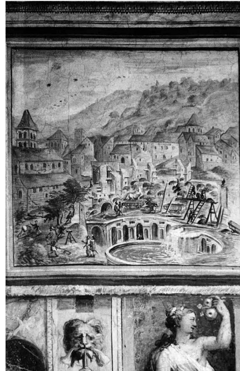
52. Atelier de Cesare Nebbia, La Fontaine de Tivoli en construction , vers 1569, fresque. Tivoli, villa d'Este, première salle tiburtine.
