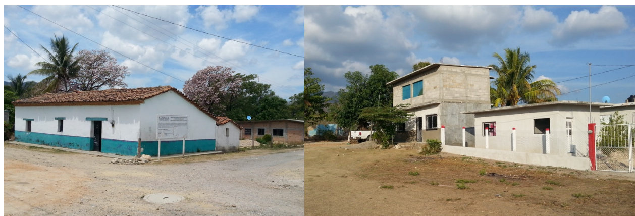
Imagen 11. Casas tradicionales y construcciones modernas (autora)
