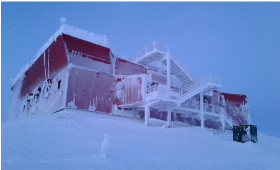
Figure 1-15 Photo de la façade nord du bâtiment principal du laboratoire de recherche atmosphérique en environnement polaire (PEARL Ridge Lab).
