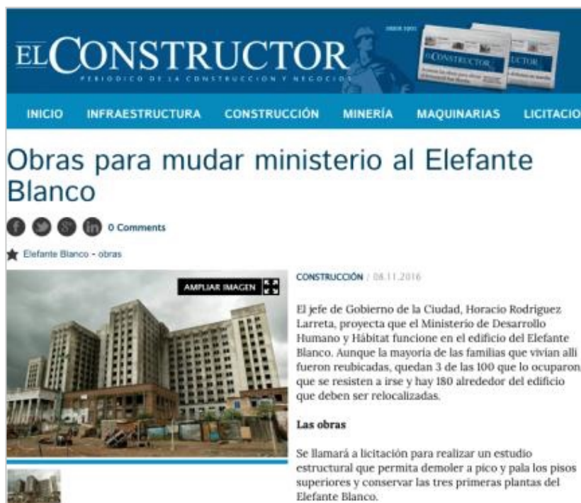
Figure 6-67 - Capture d’écran de l’article « Obras para mudar ministerio al Elefante Blanco » détaillant le scénario de démolition des étages supérieurs de El Elefante Blanco pour ne conserver que ses trois étages inférieurs et y implanter le ministère du Développement social.
