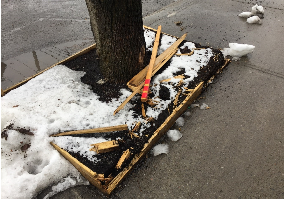
Figure 39 : Aménagement endommagé par les travaux de déneigement. Photo : Lena Payen, 2017
