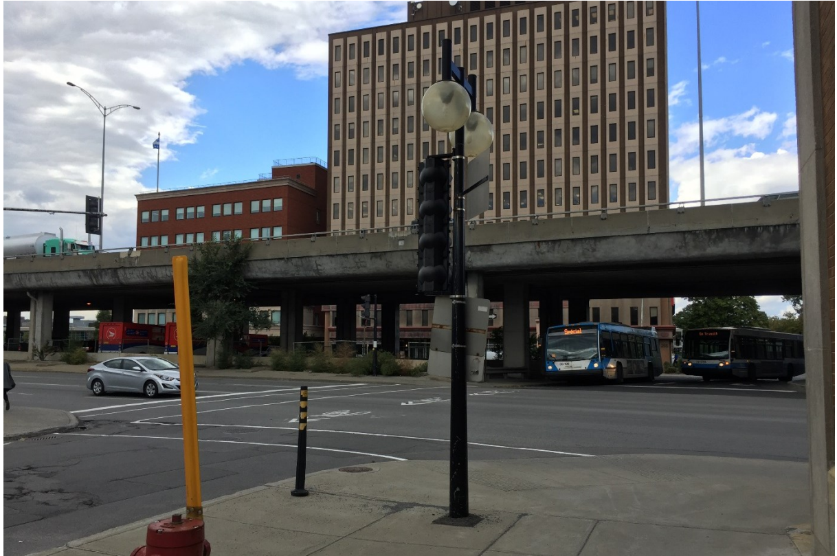
Figure 29 : Arrivée sur le boulevard Crémazie. Photo : Lena Payen, 2016
