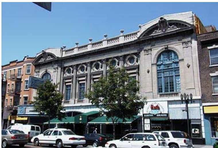
Figure 1 : Le cinéma Rialto, avenue du Parc à Montréal, est construit en 1923 selon les plans de Joseph-Raoul Garipey (architecte) et Emmanuel Briffa (décorateur).
