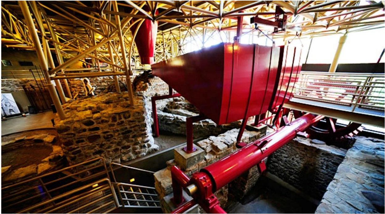
Fig. 3 Le Haut Fourneau, Forges du Saint-Maurice. Photo : Parcs Canada
