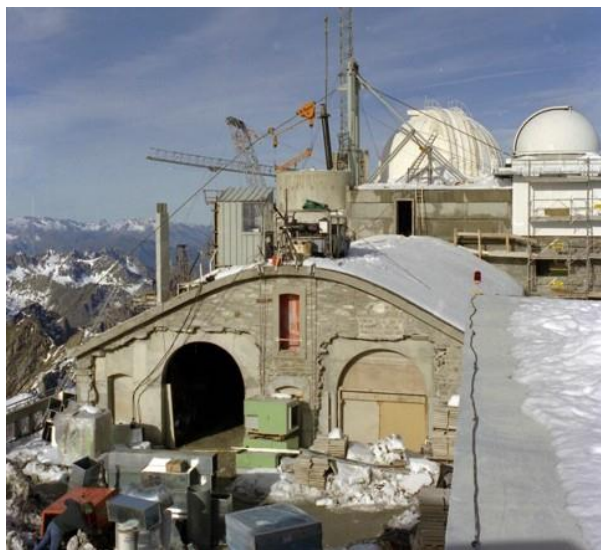
Fig. 12 : Le Pic-du-Midi (France) : Un site d'altitude régulièrement en chantier, tant pour des raisons de maintenance que d'adaptation de l'outil scientifique et de ses conditions d'utilisation, campagne de travaux de 1997-98 © Régie du Pic-du-Midi
