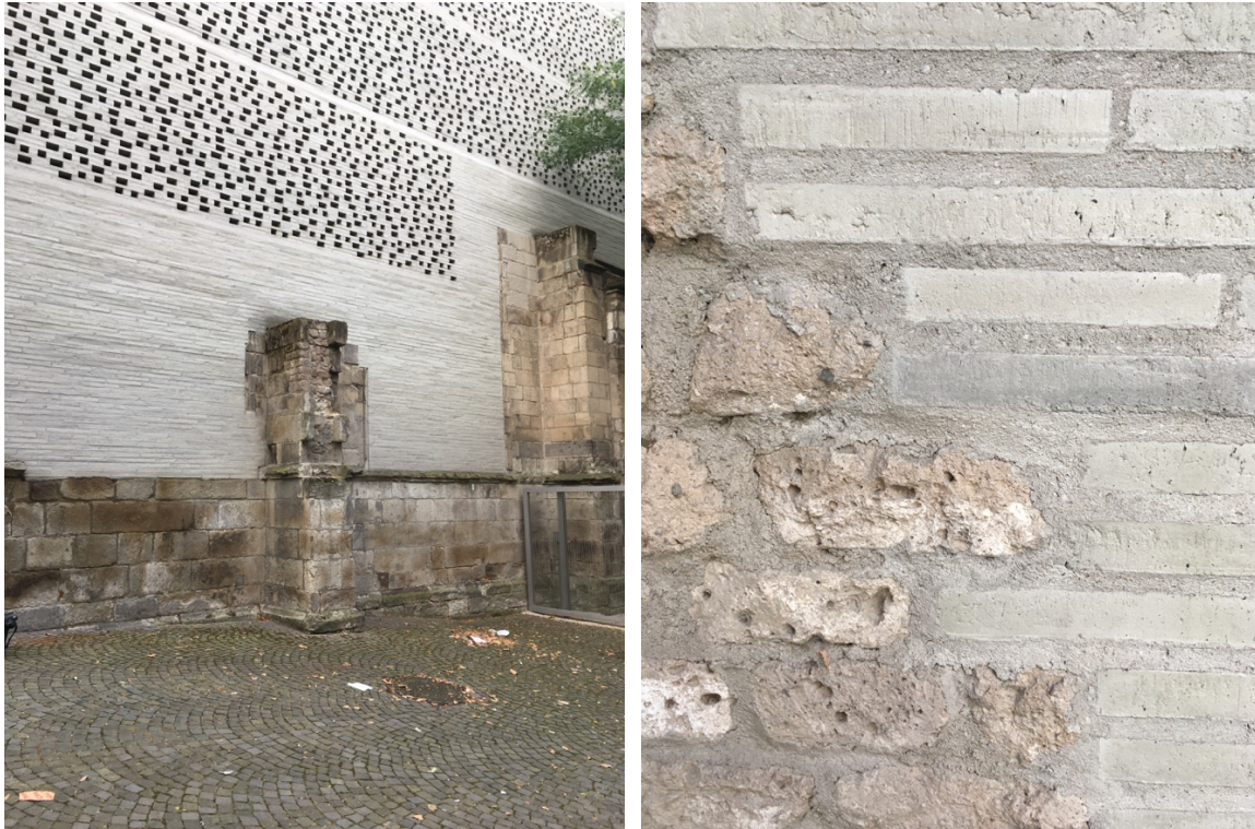
Figure 22. Ancienne et nouvelle maçonnerie, Musée Kolumba
