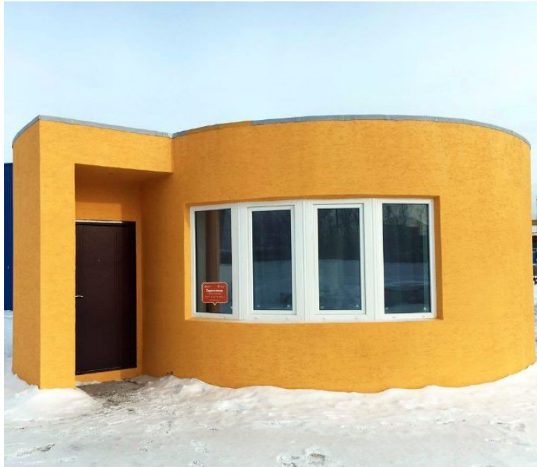
Figure 28 : Vue extérieure de la maison réalisée grâce à l'impression 3D par la firme Apis Cor.
