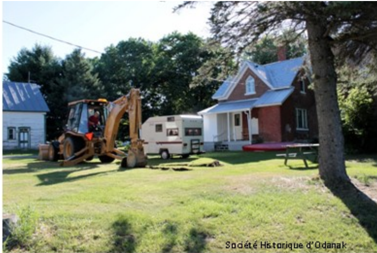
Figure 12 : Excavation à la pelle mécanique
