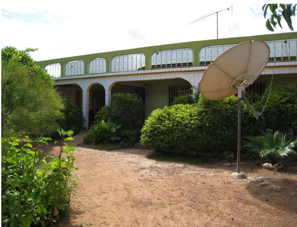
Concession urbaine, de la Maison des Projets. Ancienne cour polygyne
