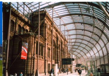
Fig. 28. Malon, Arnaud. The inside of the glass construction. 31 juill. 2008. Wikimedia Commons . Web. 3 août 2016. https://commons.wikimedia.org/w/index.php?title=File:Strasbourg_Railway_Station_inside.jpg&oldid=123882718 >.
