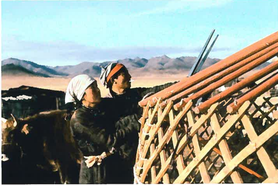
Photo 9: Le montage de la ger avec au premier plan le treillage en bois composé de khana (Peter Foggin).
