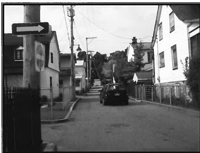
Fig. 17 - Aménagement routier du Vieux-Wendake
