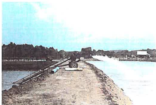
Photo 24: Pompage des eaux du bassin vers le système de canalisation.
