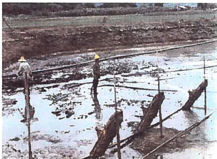
Photo 32: Nettoyage des pédalos d'aération à l'aide d'arrosiers à haute pression. (cliché E. Dricot, juin 2001)
