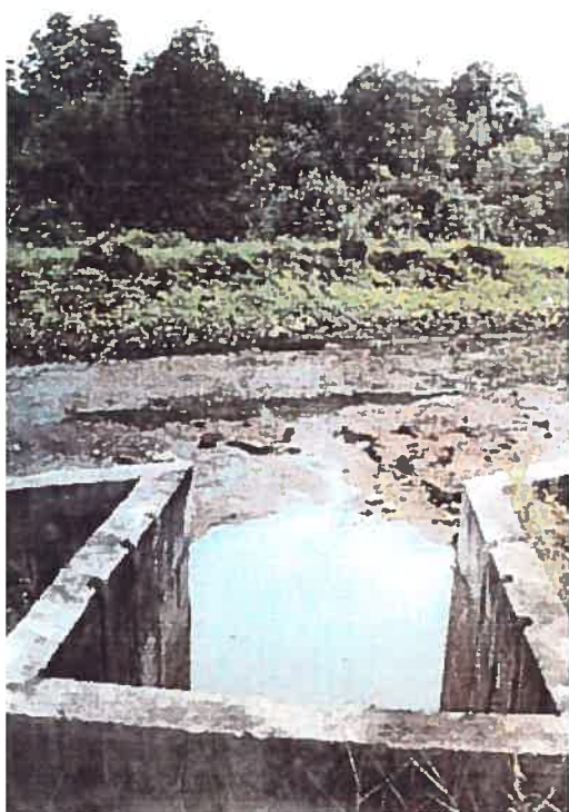
Photo 34: Porte de sortie des eaux usées vers le canal de drainage qui longe la forêt de mangrove. (cliché E. Dricot, juin, 2001)
