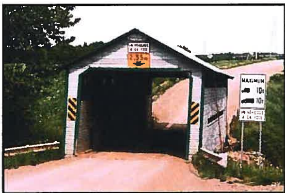
Figure 1. Le pont Pierre-Carrier (61-42-05) dont l'ouverture est très étroite au centre du mur.
