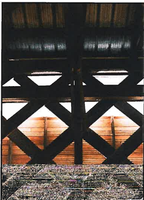
Figure 3. L'intérieur du pont Prud'homme (61-71-01) où l'on aperçoit les tâches brillantes ou mattes de l'acier galvanisé.
