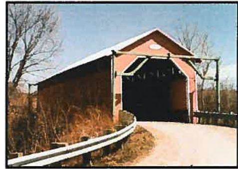
Figure 15 et 16. Le pont Étienne-Poirier (61-51-03) à deux époques différentes. Les garde-fous en bois à gauche et en métal sur madrier de bois traité à droite.
