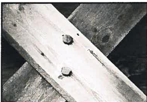
Figure 5. Les chevilles de bois du pont de ferme-rouge (61-33-02).
