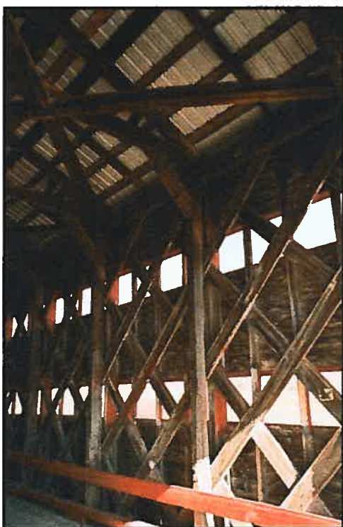
Figure 3. La ferme Town élaboré du pont Lambert (61-44-08) situé dans la région de Mégantic.
