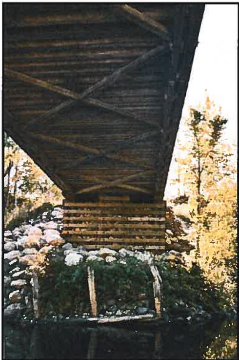
Figure 1. Le tablier du pont de l'aigle (61-25-11) vue du dessous.
