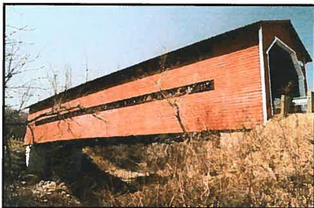
Figure 2. Le pont Des Raymonds (61-51-01) dont le lambris à feuillure est installé à l'horizontale.
