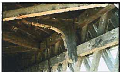
Figure 10 et 11. Le pont McVetty-McKerry (61-18-08), dont on voit le corbeau ci-haut et une jambe de force à même un tronc d'arbre ci-bas.
