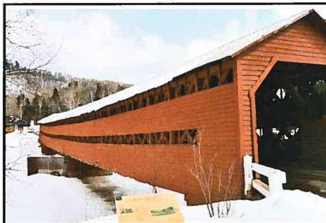
Figure 5. Un des ponts jumelés de Ferme-Rouge (61-33-02 et 03) dont le pilier est à caisson de bois lambrissé.
