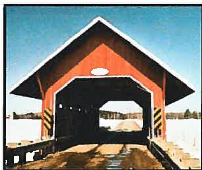
Figure 5. Le pont Guthrie (61-45-01) dont la toiture est très en pente.
