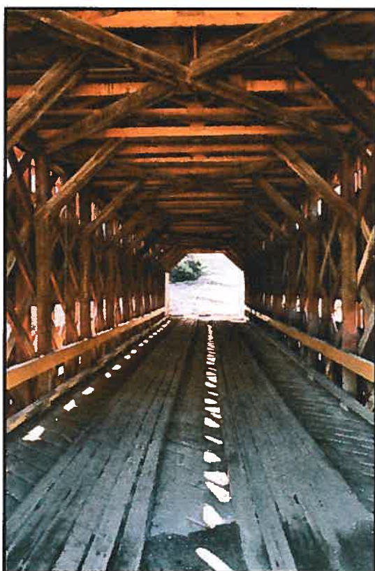
Figure 2. Le tablier du pont Kelly (61-25-13) où l'on voit la surface de roulement installée obliquement et deux rousières longitudinales.
