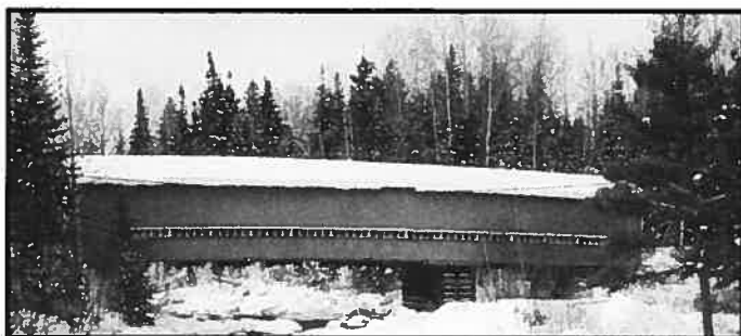
Figure 1. Le pont du lac Ha! Ha! (61-17-04) dont le lambris est en tôle ondulée, exemple unique au Québec.
