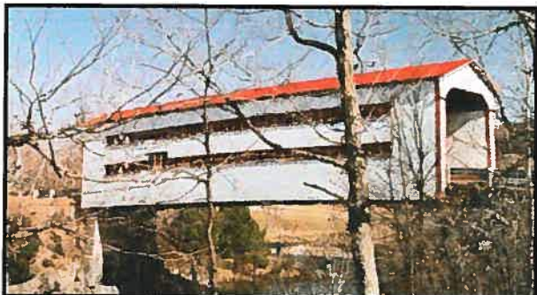
Figure 5. Le pont Lambert (61-44-08) dont le revêtement en acier prépeint est en panneaux à côtes.
