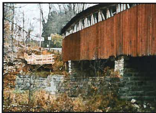
Figure 9. Le pont Powerscourt (61-27-01) dont les fondations sont en pierre de taille à assises régulières.
