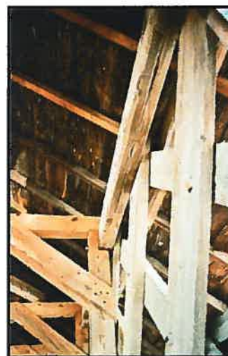
Figure 4. Le pont Guthrie (61-45-01) où l'on voit un exemple d'épaulement.
