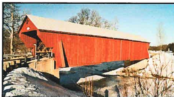
Figure 4. Le pont Freeport (61-45-01) dont le revêtement métallique est en aluminium prépeint à joint pincé.
