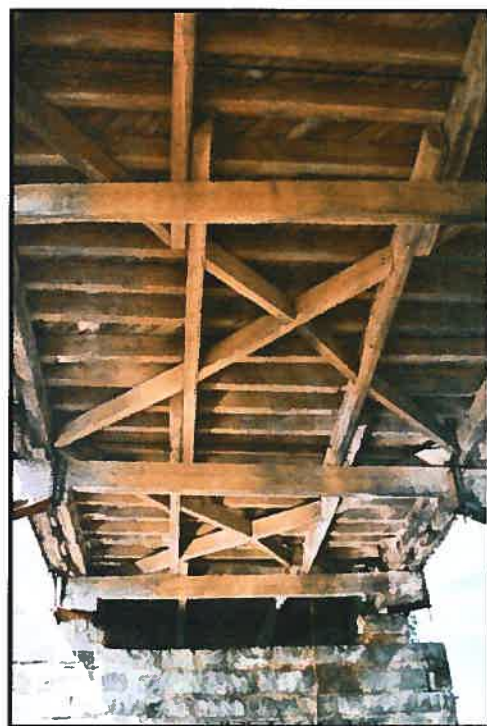
Figure 3. La structure du tablier du pont McVetty-McKerry (61-18-08).
