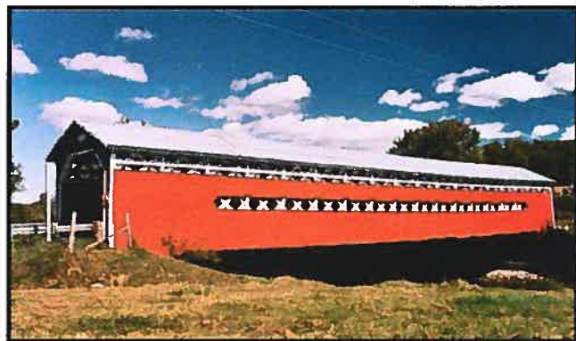
Figure 2. Le pont Prud'homme (61-72-01) recouvert d'un revêtement en acier galvanisé en panneaux à côtes d'environ quatre pieds de large.
