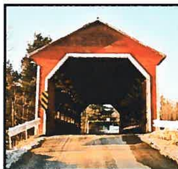
Figure 6. Le pont Balthazar (61-11-01) dont la pente de toit est peu prononcée.
