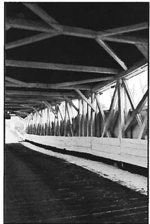
Figure 10. Pont de Powerscourt (61-27-01). Croisillons et contreventement droits.
