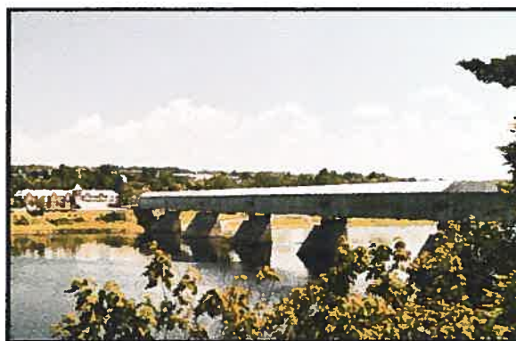
Figure 3. Le pont Hartland (55-02-07) dont les fondations en béton ont des becs en forme d'ogive.
