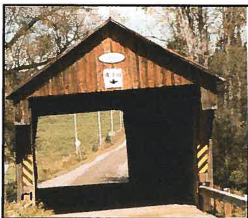
Figure 3. Le pont McDermott (61-18-06) dont le recouvrement est installé verticalement.
