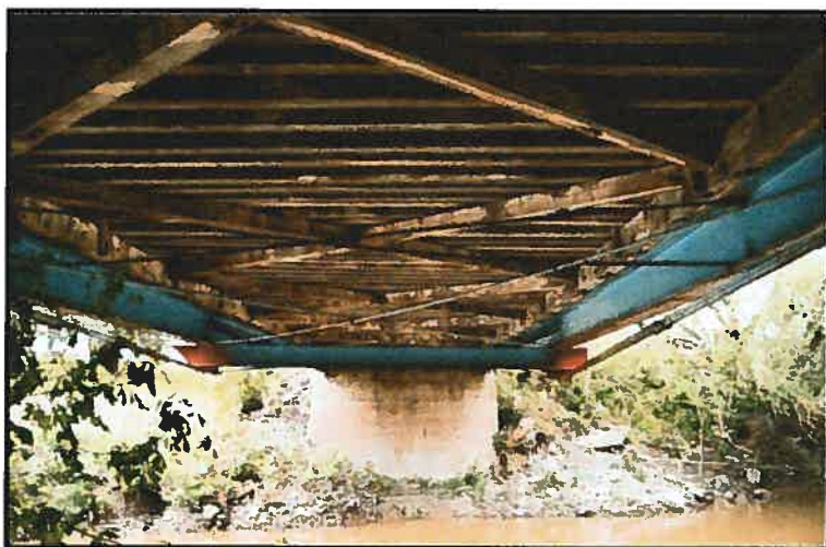
Figure 4. Les poutres métalliques du pont Grandchamp (61-09-02) ajout postérieur à la construction venant supporter les cordes inférieures des fermes structurales.
