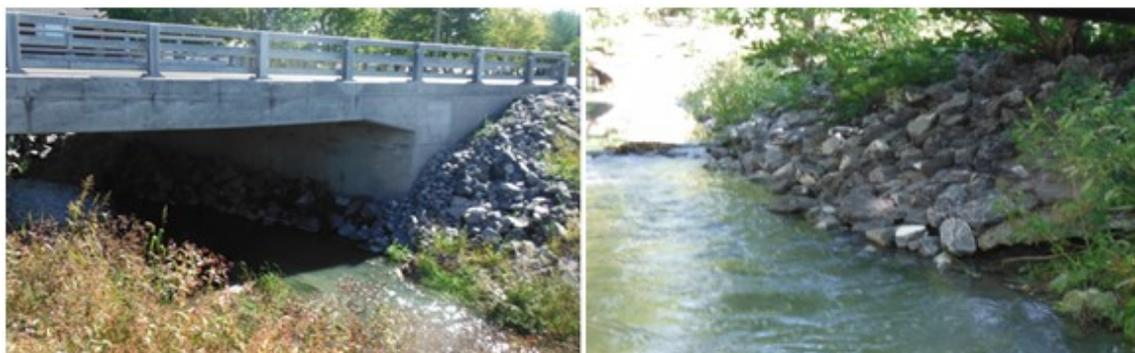
L'énrochement est généralement employé pour résoudre des problématiques liées au domaine de la construction, aux enjeux environnementaux ainsi qu'à des fins de sécurité publique. L'énrochement est utilisé afin de limiter les processus naturels d'érosion dans les rivières pour protéger les infrastructures à proximité des routes (US DoT 1989 , ATC 2005), pour stabiliser les berges lorsqu'il faut contrôler des phénomènes d'érosion (Avery 1995) ou
