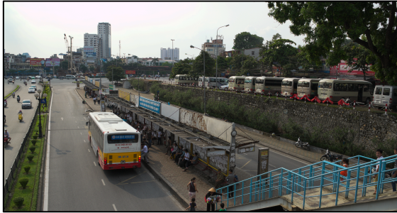
Photo 2.1 : Station Cầu Giấy (Source : Auteur, 2014)
