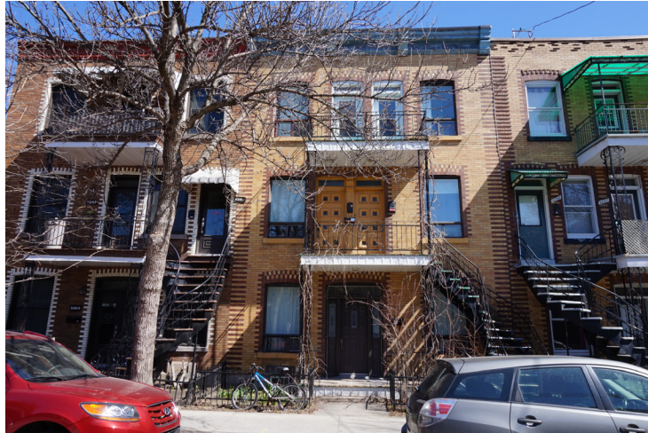
Figure 9: Triplex, rue Chabot, PE (source : photographie prise par l'auteur)
