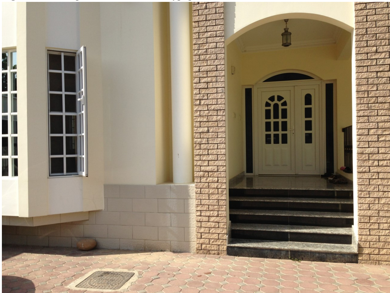
Figure 40 : Exemple de la surélévation typique des maisons omanaises
