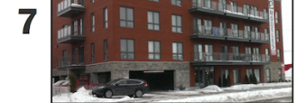
7 12 clé de la gare (2012) Type: condominiums Promoteur: Équipe Landco CCDEV Description: 4 étages; 44 unités de logement
