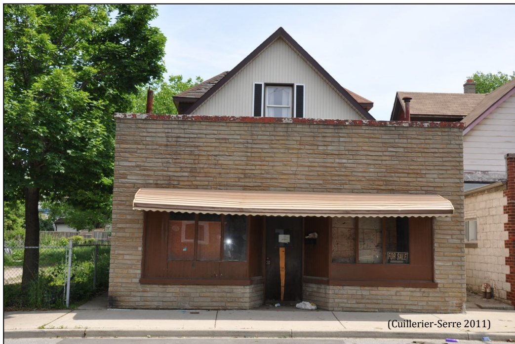
FIGURE 4,10 : COMMERCE ABANDONNÉ AVEC RÉSIDENCE OCCUPÉE AU DEUXIÈME ÉTAGE, FORD CITY
