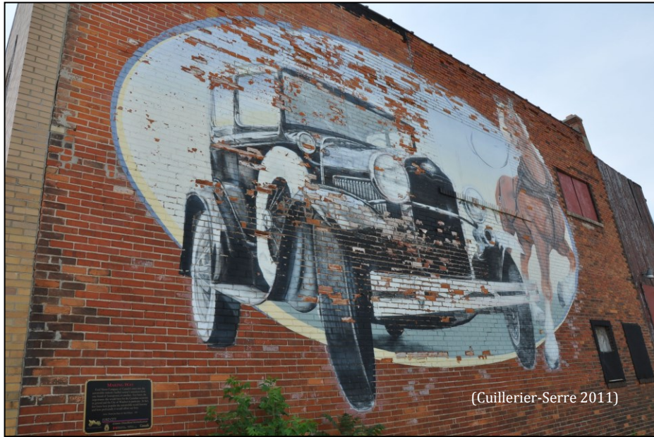
FIGURE 4,7 : MURALE NÉCESSITANT UNE RESTAURATION, FORD CITY
