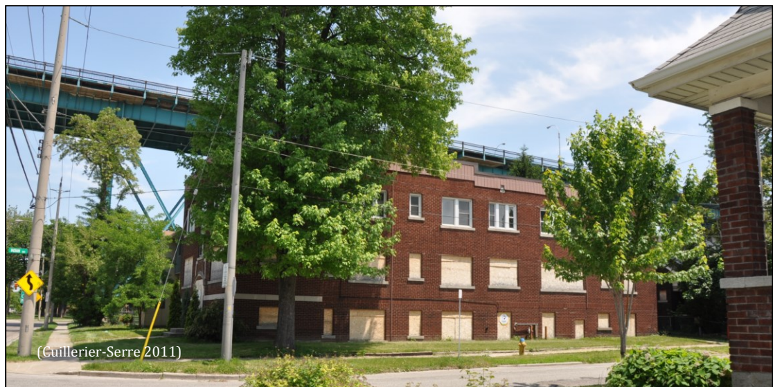
FIGURE 4,21 : IMMEUBLE RÉSIDENTIEL PLACARDÉ ADJACENT À L'AMBASSADOR BRIDGE
