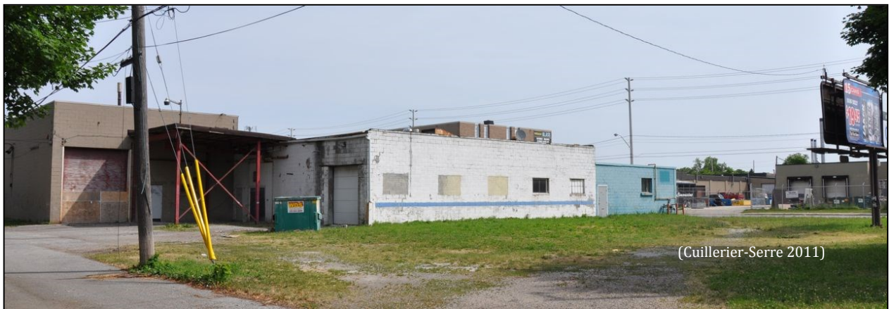
FIGURE 4,16 : IMMEUBLE COMMERCIAL ABANDONNÉ, FACE AU CÔTÉ NORD DU CASINO
