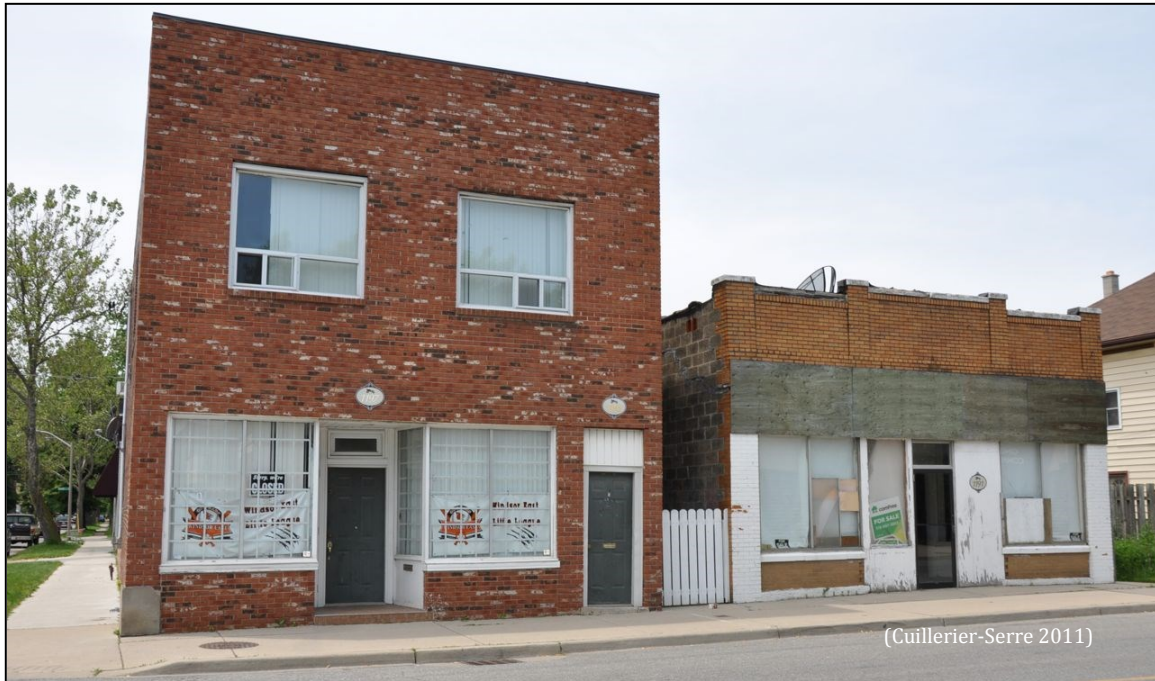
FIGURE 4,11 : COMMERCE ABANDONNÉ AVEC RÉSIDENCE OCCUPÉE AU DEUXIÈME ÉTAGE, FORD CITY
