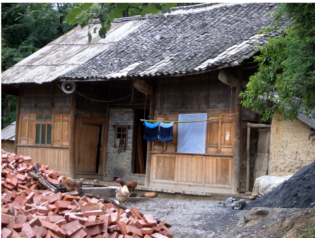
Photo 5 Maison en bois et en briques construite dans les années 1980 (village de Dazhai, mars 2008)
