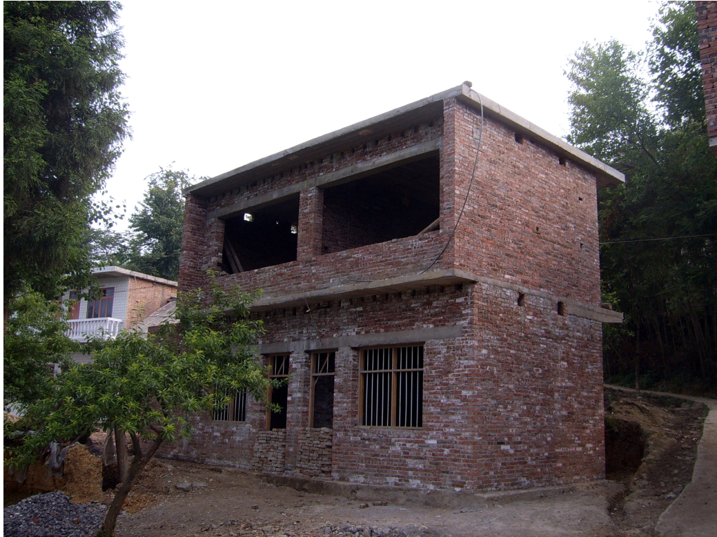
Photo 6 Maison en briques à deux étages en construction (village de Dazhai, mai 2008)
