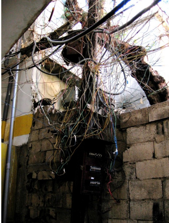
Figures C.9 et C.10 Raccordements électriques. Inutile d'insister sur les dangers que représentent de telles installations...
