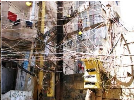
Figures C.9 et C.10 Raccordements électriques. Inutile d'insister sur les dangers que représentent de telles installations...
