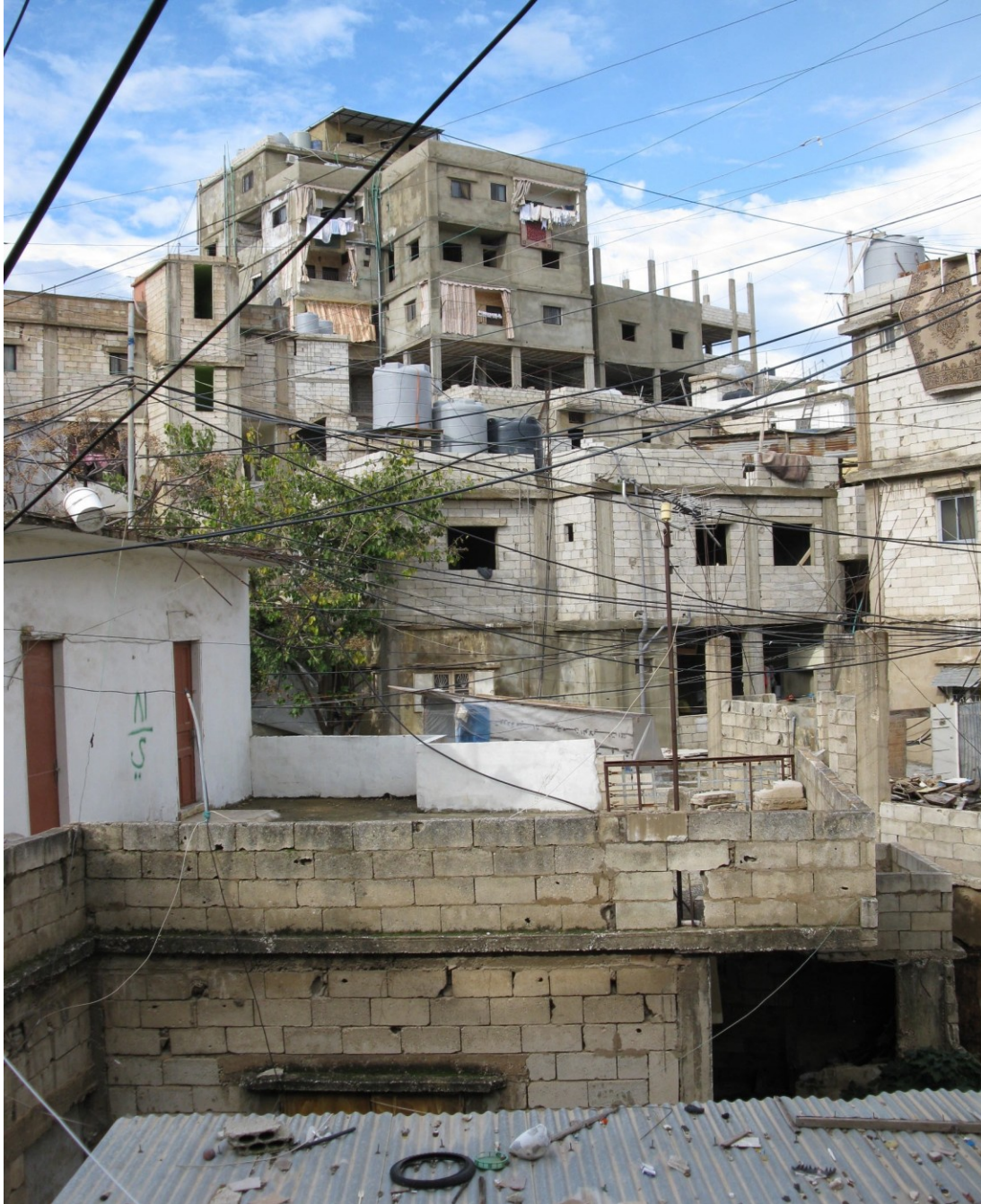
Figure C.3 Habitations érigées les unes sur les autres. Les constructions sont souvent inachevées.
