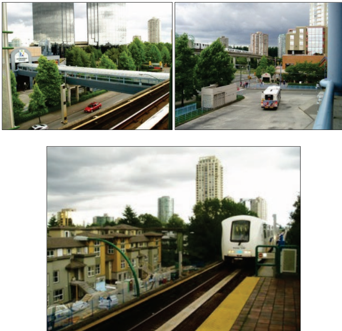
Figure 3-3 : Exemples de développements urbains de type « TOD » (denses et mixtes) dans le Grand Vancouver, autour de stations du Sky Train
