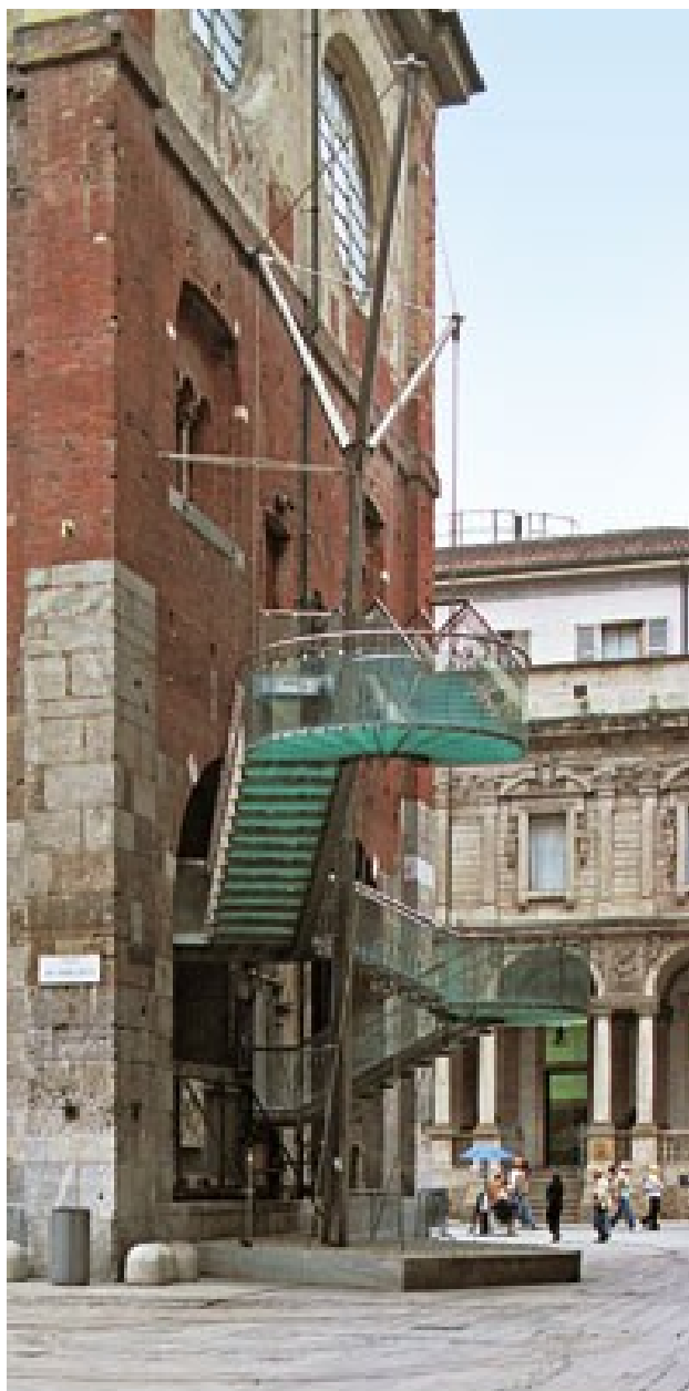
Figure 18: Exemple de projet du nouveau en tant qu'insertion (marqué de la culture du projet contemporain). Projet de Marco Dezzi Bardeschi, escalier de secours, Palazzo della Ragione, Milan, 2002. Source: http://www.marcodezzibardeschi.com/_Progetti/Realizzati.html , août 2011
