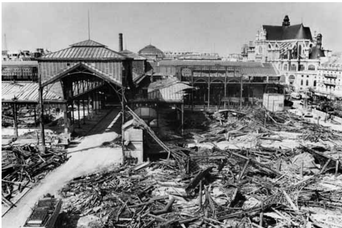
Figure 15: Démolition des Halles de Paris 1852-1870 et 1936. Les Halles furent construites dans le style Baltard qui conjugue le fer, la fonte et le verre. Elles furent démolies en 1971 et 1973 pour permettre la construction de la gare et du Forum des Halles en 1975-1979 par l'architecte Claude Vasconi. 263
