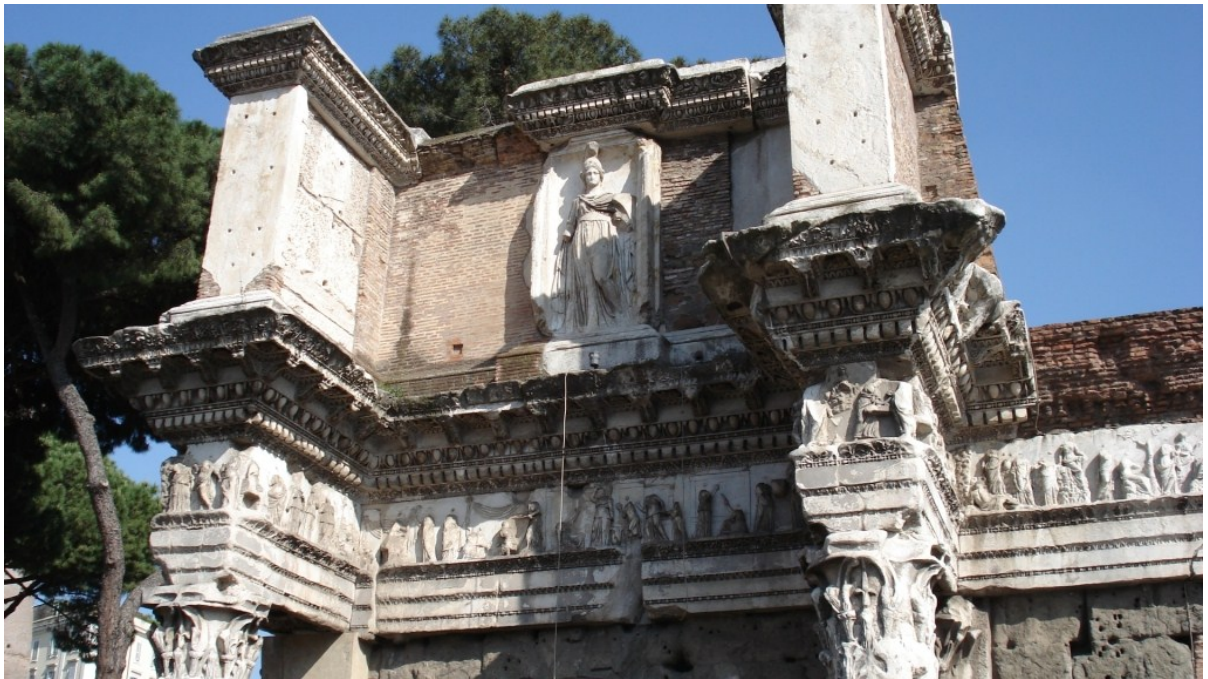
Figure 5: Exemple de reconstruction (anastylose) des parties manquantes en briques à la fin du XIXe siècle. Le colonnade, Foro di Nerva, Rome, 97 apr. J.-C. Photo de l'auteur, 2007.
