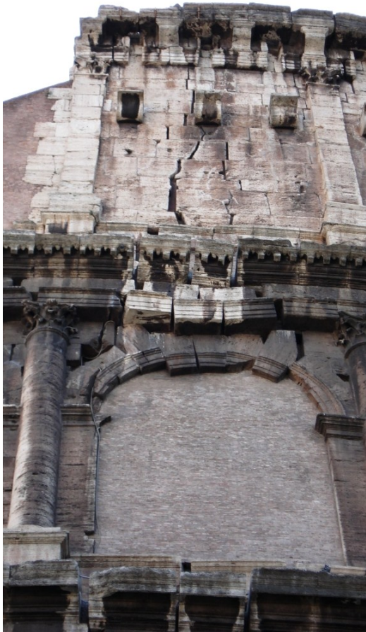
Figure 7: Référence, option de Raffaele Stern, Giuseppe Valadier. Colisée, 70-80 apr. J-C., Rome. Après un violent tremblement de terre, consolidation des arches médianes par un contrefort massif par Raffaele Stern entre 1817-1820. Dans la figure de droite, Stern semble vouloir arrêter les effets du temps. Photos de l'auteur, 2007.
