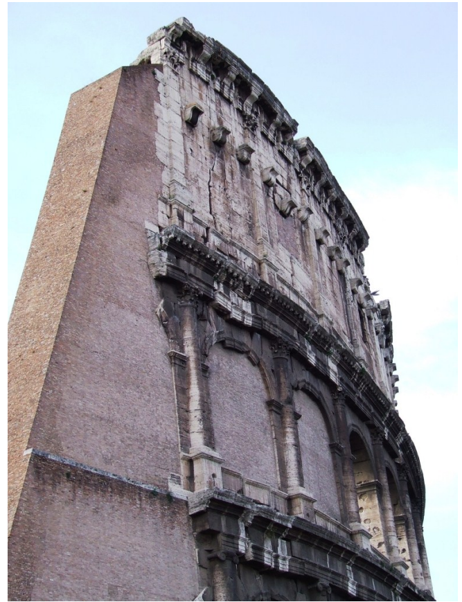
Figure 7: Référence, option de Raffaele Stern, Giuseppe Valadier. Colisée, 70-80 apr. J-C., Rome. Après un violent tremblement de terre, consolidation des arches médianes par un contrefort massif par Raffaele Stern entre 1817-1820. Dans la figure de droite, Stern semble vouloir arrêter les effets du temps. Photos de l'auteur, 2007.
