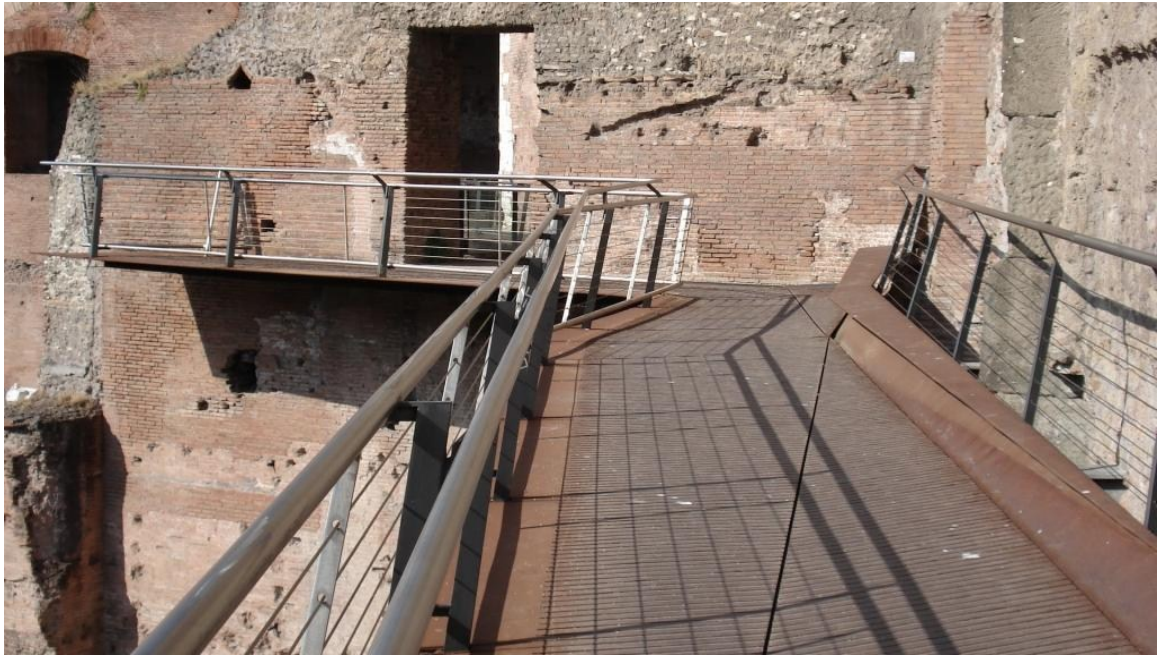
Figure 34: Projet d'actualisation dans un site archéologique. Ajout d'une rampe contemporaine, Foro di Nerva o Transitorio, Rome, Italie, inauguré en 97 ap. J-C. pour l'empereur Nerva. Cette rampe en acier inoxydable et corten permet d'atteindre le niveau ancien de l'édifice. Photo de l'auteur, 2007.
