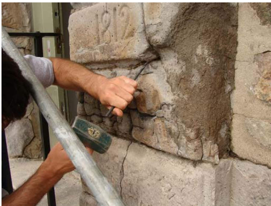
Figure 23: Exemple de conservation préventive sur le portail du Fort Chambly, Chambly, Québec. Nettoyage des fissures avant consolidation par le Centre de conservation du Québec. Photo de l'auteur, 2010.
