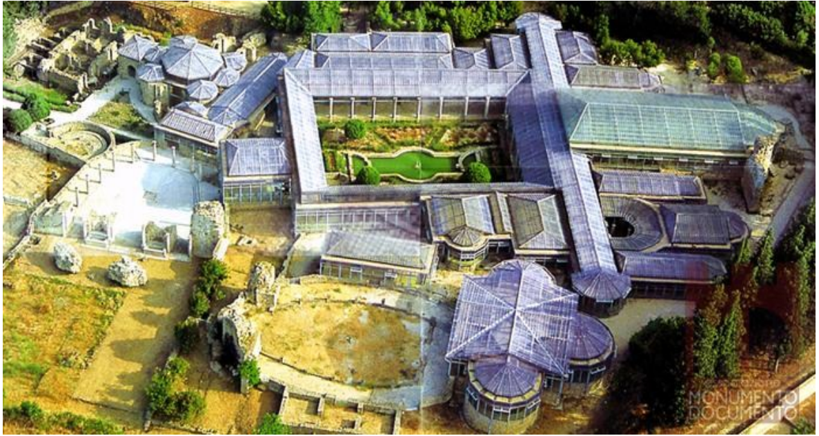
Figure 13: Représentation de la restauration critique. Piazza Armerina, Villa del Casale, Sicile, Italie, vue du complexe archéologique (1995) avec les couvertures en plexiglas, projet de Franco Minissi entre 1958-1964. Site du patrimoine mondial de l'UNESCO depuis 1997. 156
