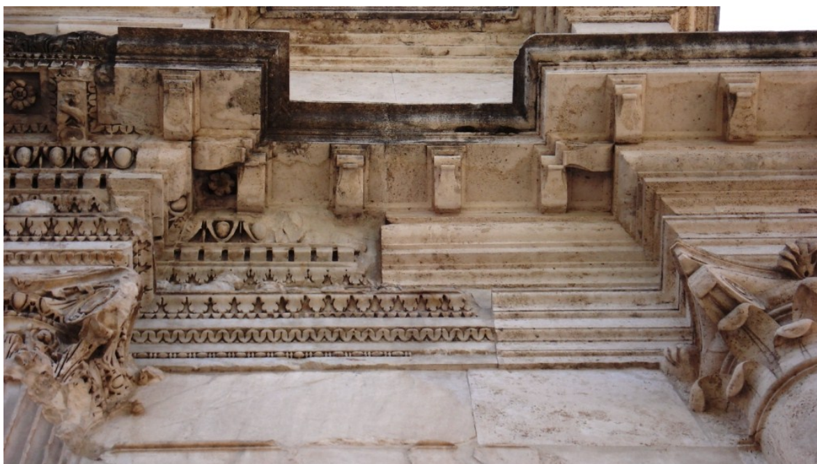
Figure 3: Exemple d'un projet illustrant les actions conservatives et restauratives. Arc de Tito, (Arcus Vespasiani et Titi), arc de triomphe romain érigé en 81 apr. J.-C., restauré par l'architecte Giuseppe Valadier entre 1819-1822 (section de droite restituée en travertin avec simplification des formes) avec la participation de Raffaele Stern décédé en 1820. Photo de l'auteur, 2007.
