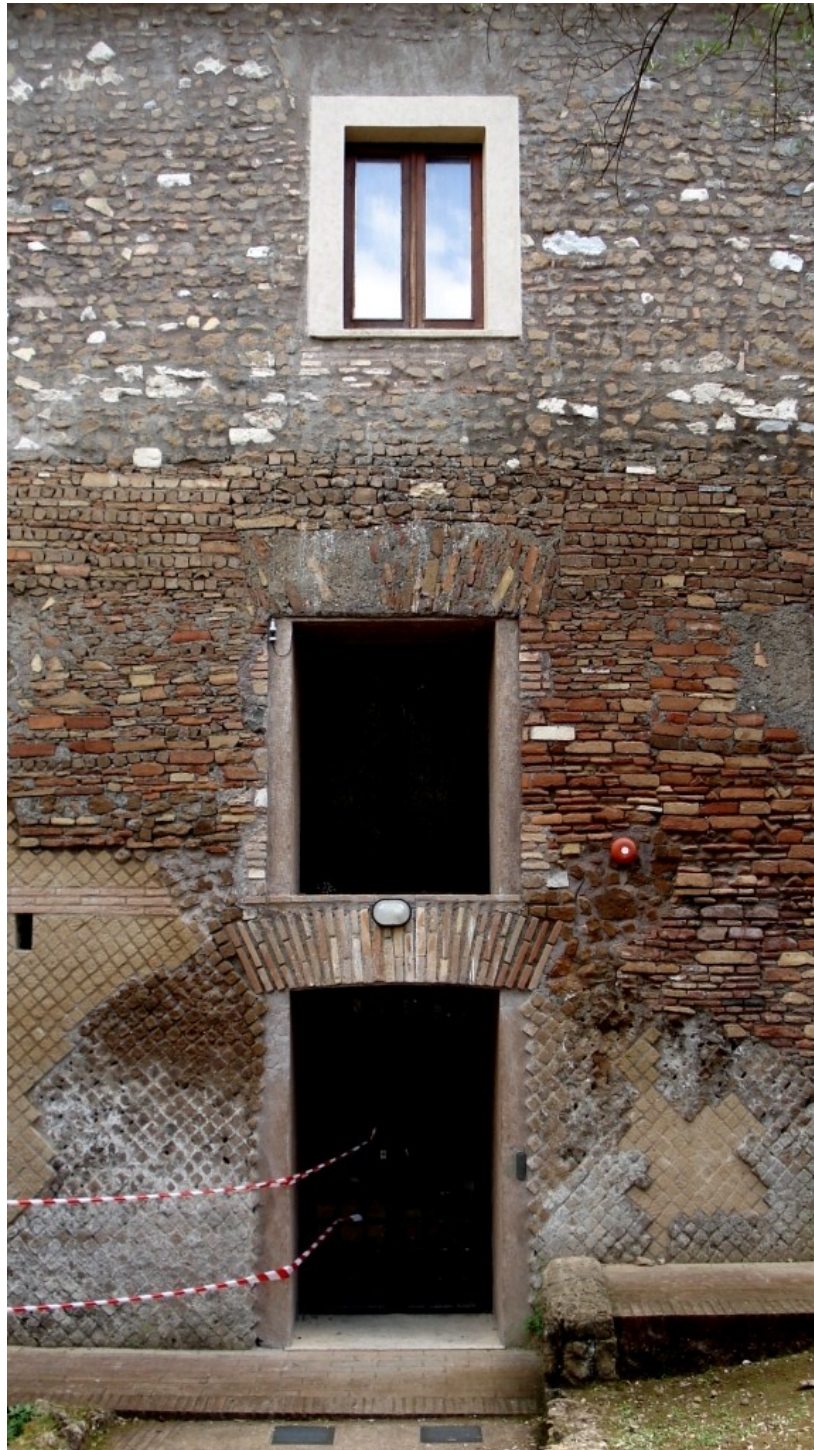
Figure 21: Exemple de facade en pierre dont la stratification complexe illustre le champ de recherche de Torsello, la stratigraphie, ainsi que les nombreuses possibilités d'interprétation, d'où son apport théorique, conserver pour connaître. Bâtiment de la Villa d'Hadrien, Tivoli, IIè apr. J.-C.. Photo de l'auteur, 2007.
