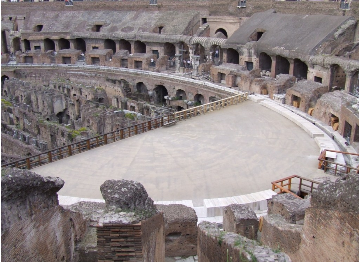
Figure 27: Exemple qui amène à réfléchir sur les objectifs de la ré-intégration et de l'actualisation. Restitution d'une section de la scène du Colisée, 70-80 ap. J.-C., Rome, Italie. Photo de l'auteur 2007.
