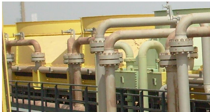
Figure 9 : Un ensemble d'aéro-réfrigérants
