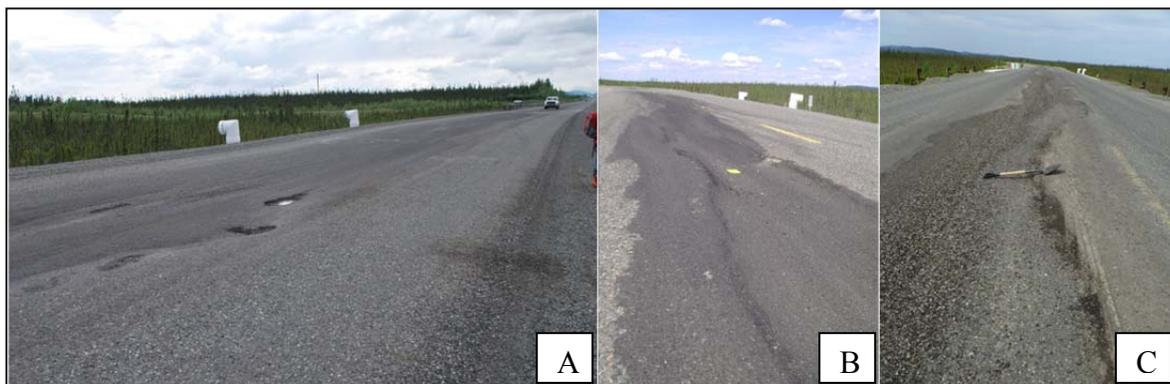
Figure 45. Dépressions observées au centre de la route au site d'étude en juin A) 2009 B) 2010 et C) 2011
