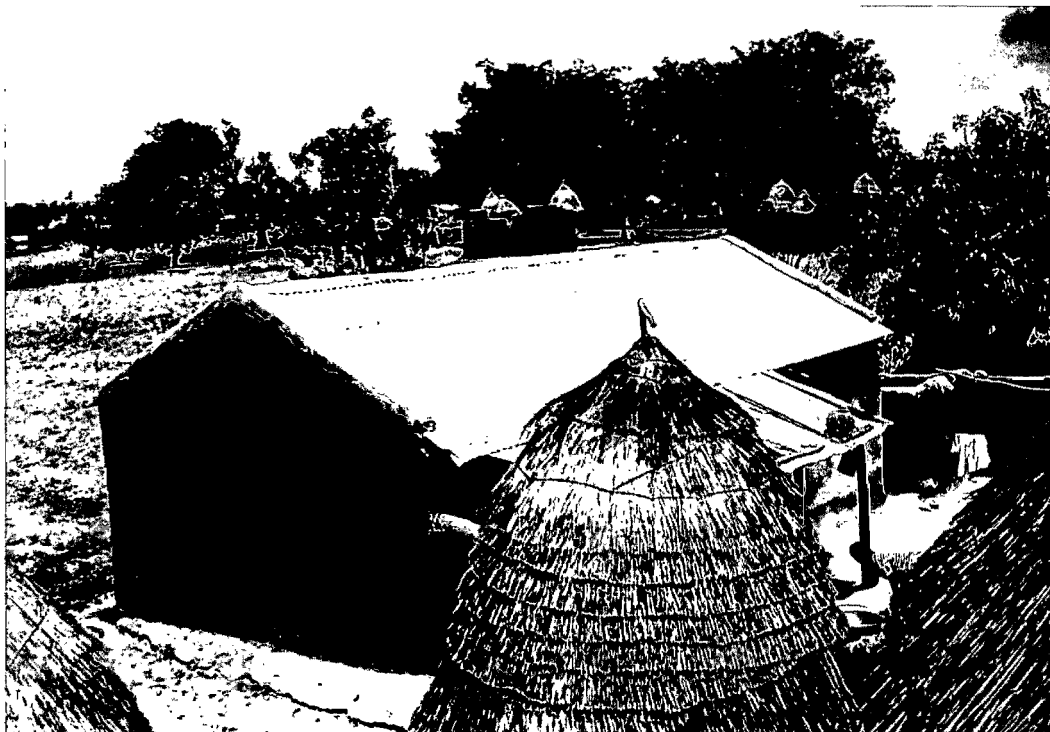
Figure 52. Vue sur le bâtiment situé du côté sud, annexe de la vieille Takienta du feu Santy.
