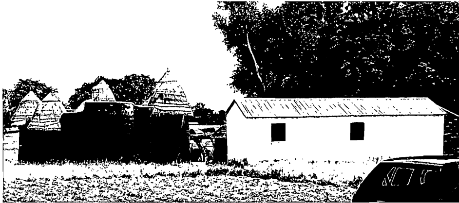
Figure 44. Case moderne en terre avec un enduit légèrement dosé au ciment plus badigeon à chaux (catégorie 3).
