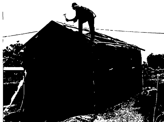
Figure 41. Travaux de charpente avec des matériaux modernes. Gaël K. Amoussou, Nadoba, juin 2007)
