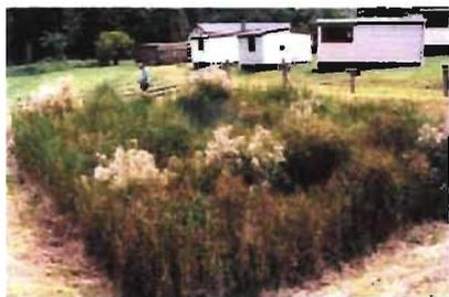
Figure. 6.31 : Le système de traitement des eaux usées, un marais sous surfacique, du site de camping à Waipoua Forest Park en Nouvelle-Zélande (source : *Wetland Solutions*, 2007).
