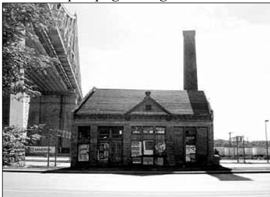
Figure 6 : Extérieur de l'ancienne station de pompage Craig en 2002
