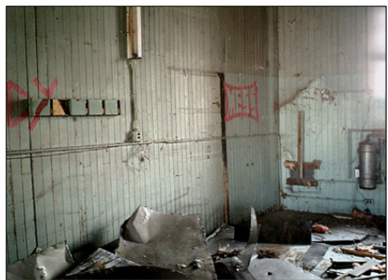
Figure 7 : Intérieur de l'ancienne station de pompage Craig en 2002
