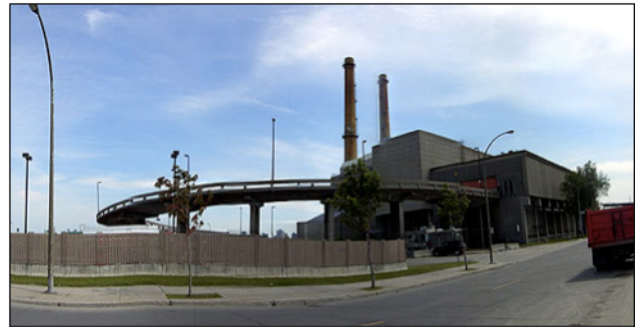
Figure 11 : Rampe d'accès de l'ancien incinérateur en 2004
