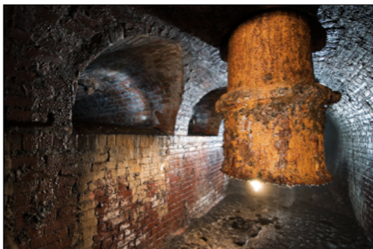
Figure 8 : Canalisations sous l'ancienne station de pompage en 2002
