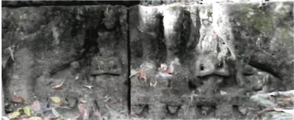
La chapelle de l'Hôpital Est (d'Angkor Thom) : Fronton effondré. À gauche, la scène de prise de pouls. Au centre, les jambes d'Avalokiteśvara. (Photo R Chhem)
