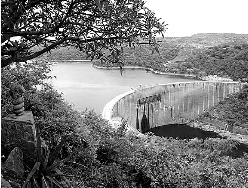
Photo 1 : Barrage, Kariba. Source : Privée.
